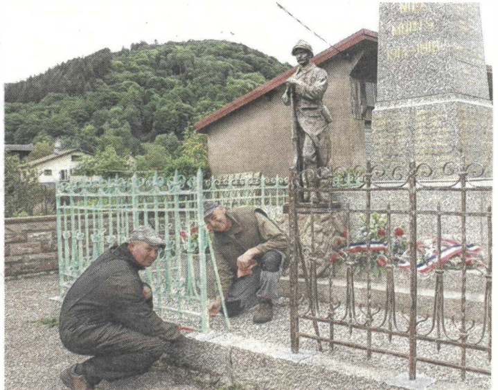
Il a fallu retirer les multiples couches de vieille peinture pour redonner de l'éclat à la barrière qui entoure le monument et en consolider certaines parties.
